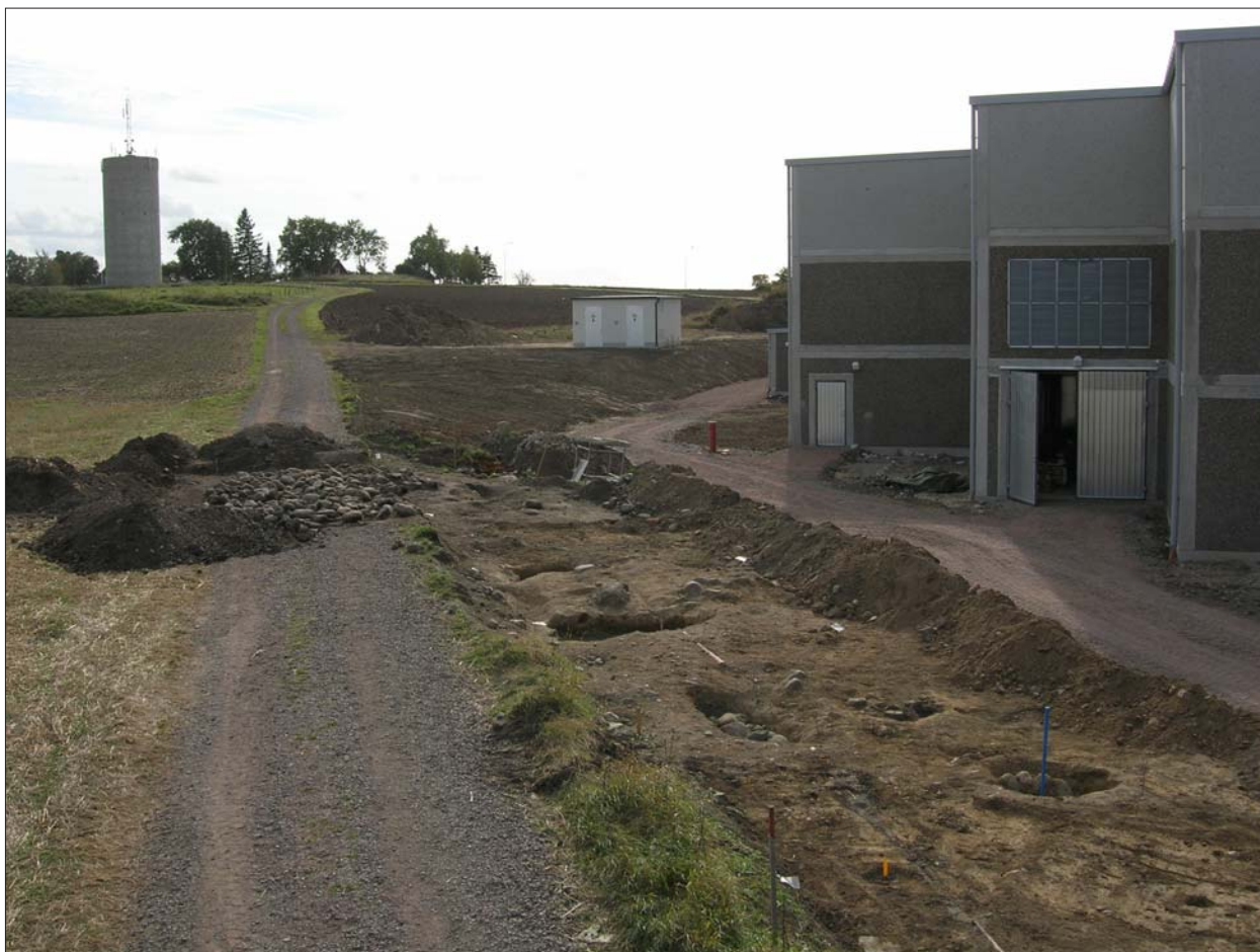
Figur 13. Den arkeologiska undersökningen pågick inom den smala markremsan närmast åkervägen samtidigt som industrilokalen byggdes. I bakgrunden syns vattentornet på backens krön. Foto (mot söder) Emma Karlsson, ÖLM.
